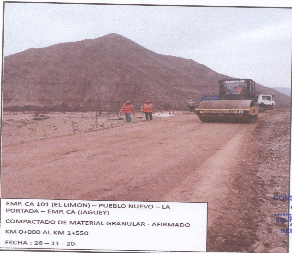
EMP. CA 101 (EL LIMON) – PUEBLO NUEVO – LA PORTADA – EMP. CA (JAGUEY) TRANSPORTE DE MATERIAL GRANULAR - AFIRMADO KM 0+000 AL KM 1+550 FECHA : 24 – 11 - 20
