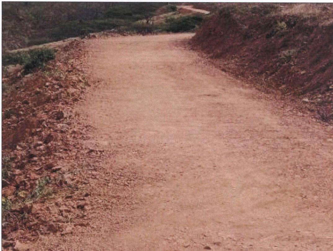
**Foto N°10:** Tramo intervenido, se evidencia la limpieza de calzada.
